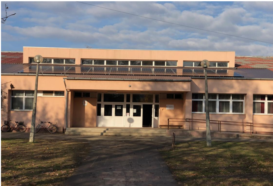
Forray Máté Általános Iskola és AMI Új Iskola Épülete:
