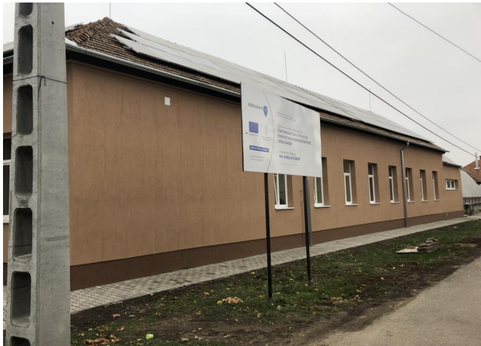
Az Új Iskola és a Kurca-Parti Óvoda épületére napelem rendszer kiépítése történik meg a beruházás során.
